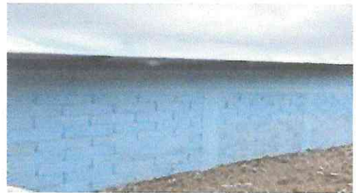
Foto 4: Pintado de paredes
