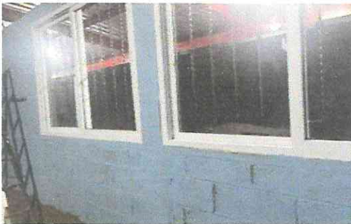
Foto 5: Instalacion de ventanas en PVC
