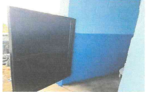
Foto 2: Mantenimiento de puertas de metal en sanitarios
